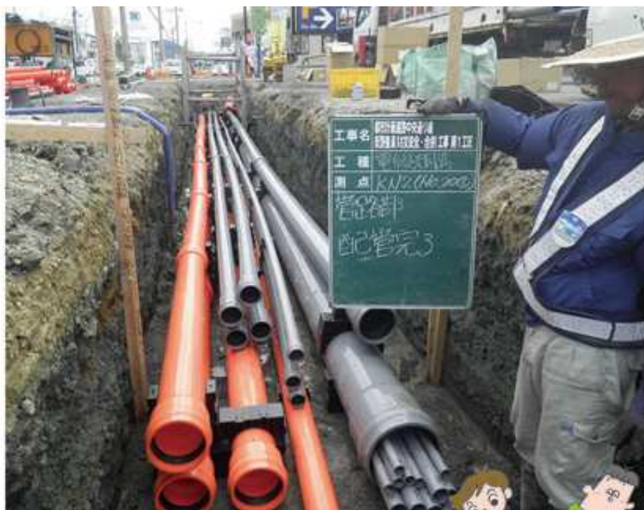
写真: 建設現場
