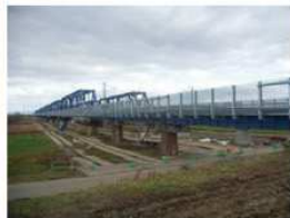
橋にとりつけられた「防風柵」。 庄内平野の丘の上に設置された「ドップラーレーダー」。
