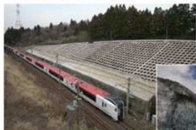
コンクリートの格子枠をつくることで、斜面を安定させ、緑化することで環境にも調和します。
