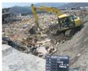
災害により、ガレキをとりのぞく作業からはじめることも。水があふれている中で、作業をすることもあります。
